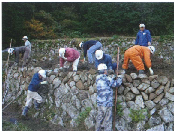
石積み作業中
