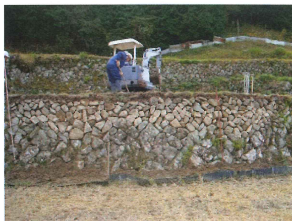
石積み作業終了後
