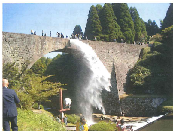
「通潤橋」放水の瞬間
